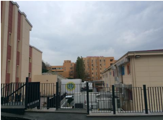
Resim 34. Yeni Temel Bilimler Amfileri, yıkılan Temel Tıp Bilimleri binasının kalıntıları ve Çocuk Hastalıkları Prefabrik Binasının arasından Dahiliye binasının görünümü
