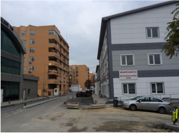
Resim 28. Dahiliye ve Cerrahi binalarının arkadan görünüşü
