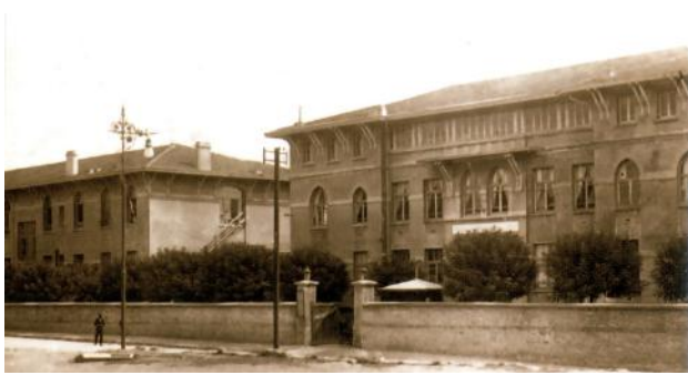
Resim 4. Merkez ve Cerrahi binaları ile eski giriş kapısı
