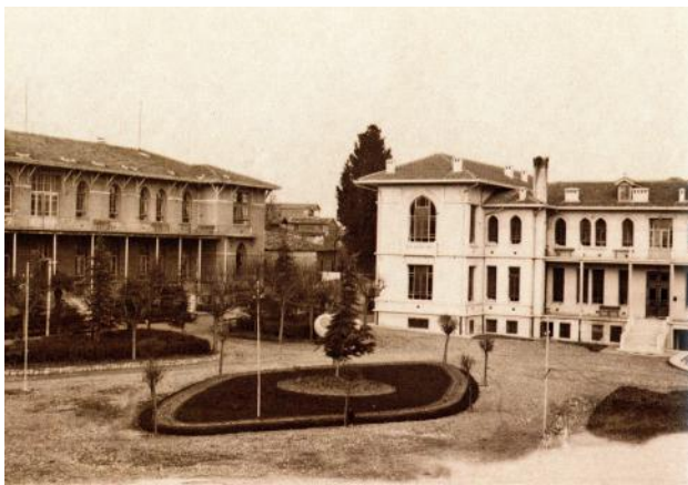
Resim 5. Dahiliye ve Cerrahi binaları
